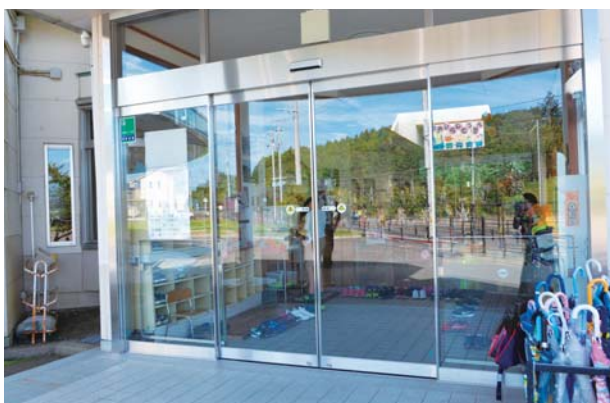
▶⑨児童館自動ドア設置工事
