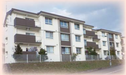
▲河原住宅1・2号棟改修
