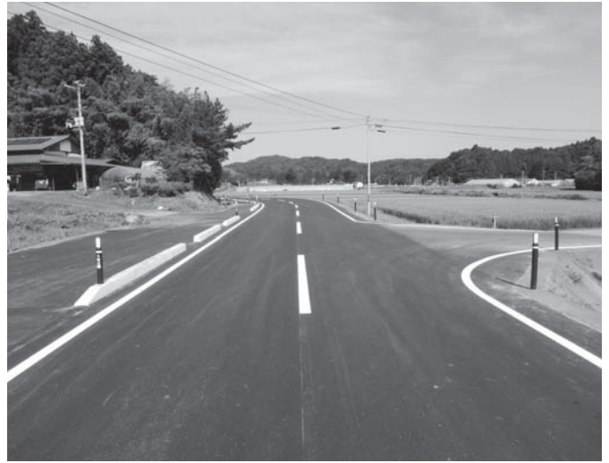
⑦大瓜南側線改良舗装工事
