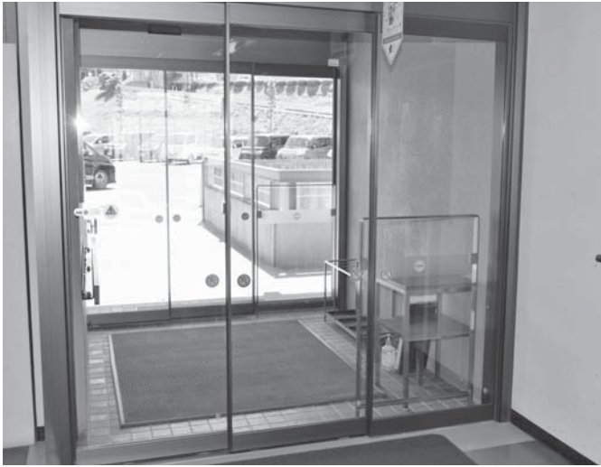
⑤平林会館自動扉設置工事
