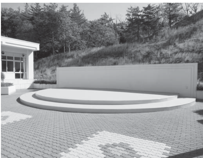
⑭大衡小学校中庭広場ステージ修繕工事
