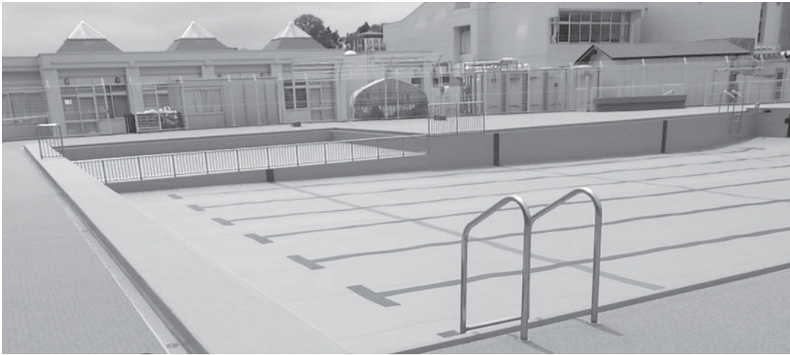
⑮大衡小学校プール修繕工事
