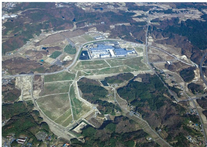
【第二仙台北部中核工業団地】
