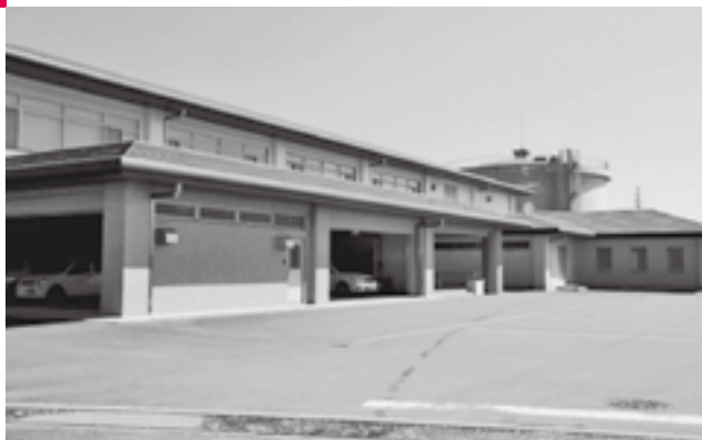
広域化拠点の水道事務所
