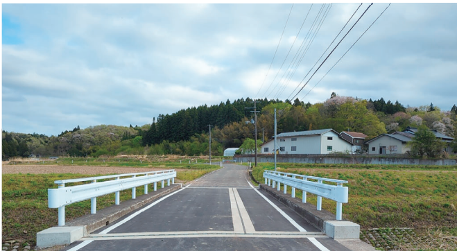
▲野田橋修繕工事
