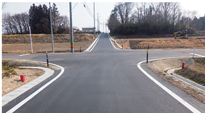
▲尾西 2 号線改良舗装工事
