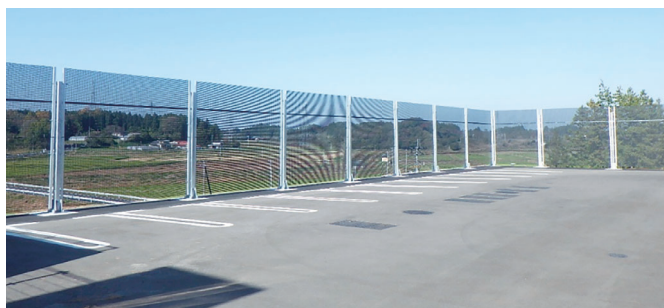
▲学校給食センター防風雪柵設置工事
