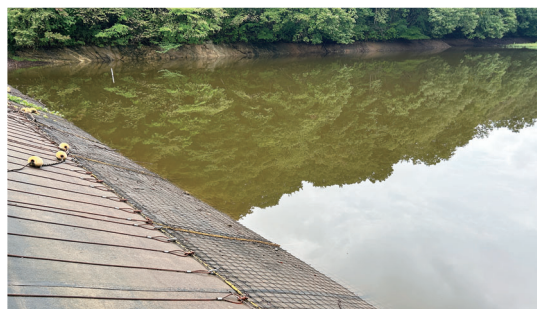
▲ため池救助ネット設置工事
