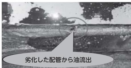
状況：送油管の裏が老朽化により穴が開き、油漏れが発生した。
