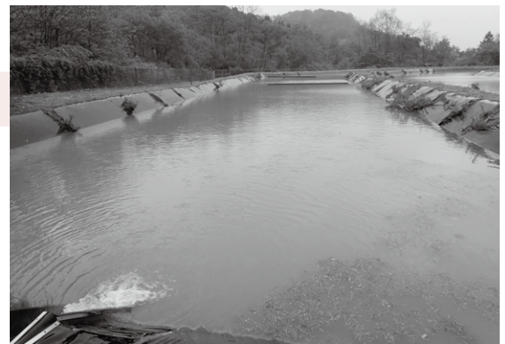
酸化鉄を自然処理する沈殿池
