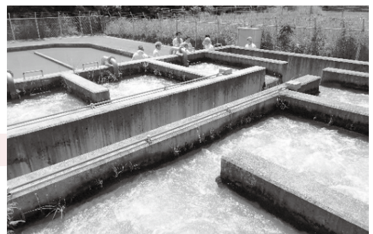
コンパクトな処理施設
