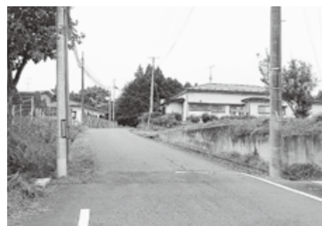
工事再開される尾西2号線
