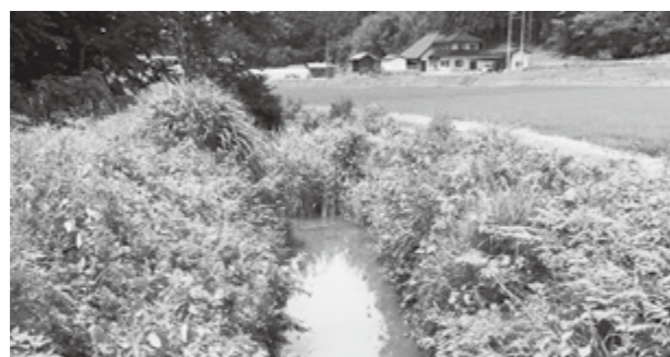
土砂が堆積している椋田川
