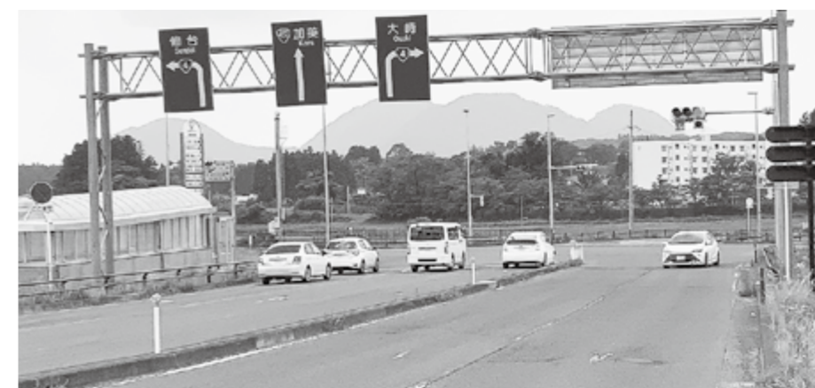
北四番丁大衡線が接続する国道4号交差点
