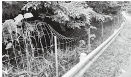
イノシシによって破損したメッシュ柵
