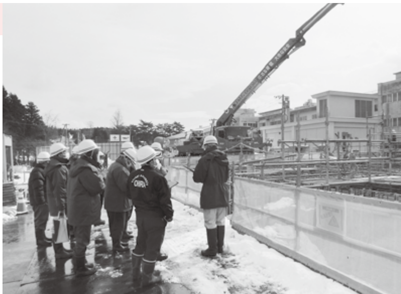
順調に進んでいる学校給食センター工事
