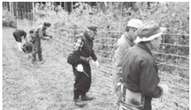
人手を要するイノシシ防止柵設置作業
