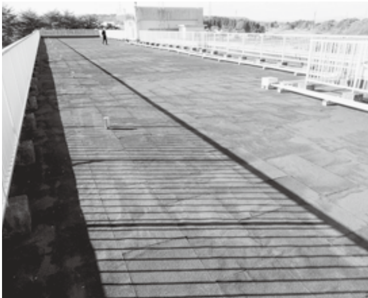
防水工事予定の中学校屋上
