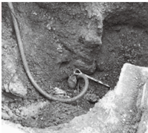
漏水調査で見出し修繕
