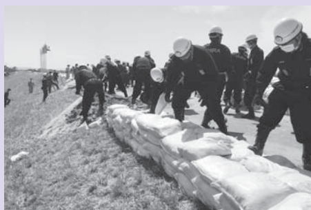
▲総合水防演習での積土のう工法訓練
