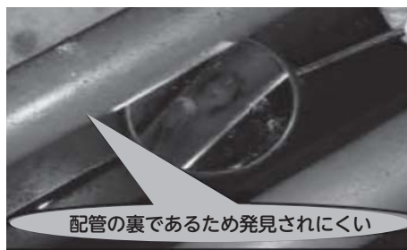
劣化した配管から油流出
