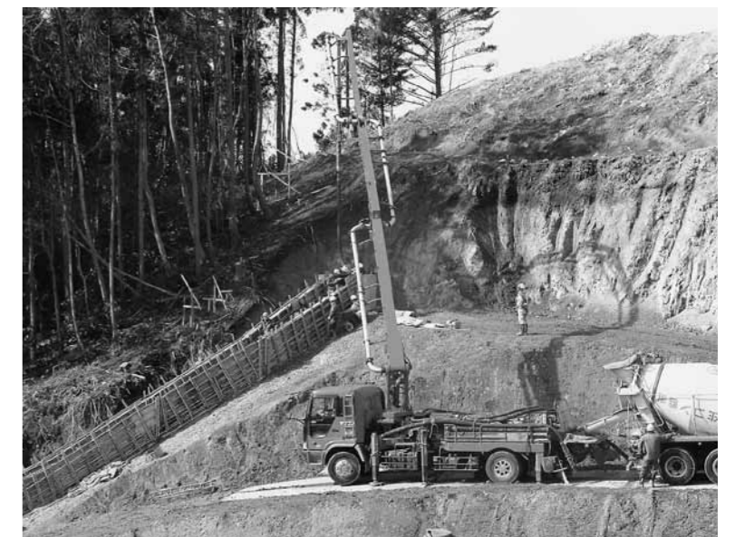
整備が進む塩浪住宅団地
