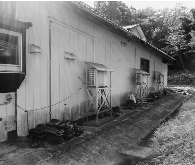
経年劣化が進む空調設備
