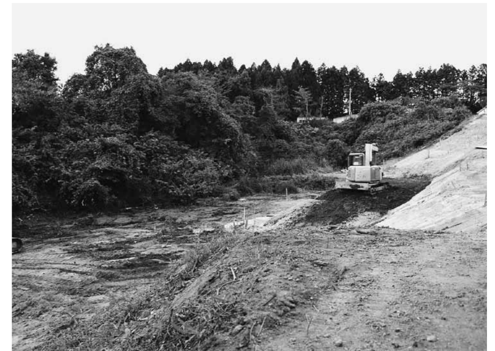
災害復旧中の農地（衡東地区）
