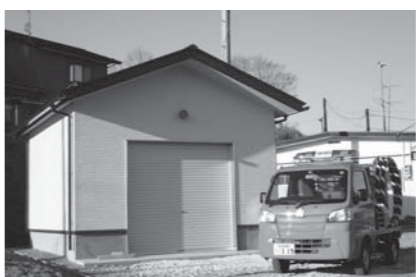
▲第6分団(奥田)に整備したポンプ小屋と小型動力ポンプ付軽積載車
