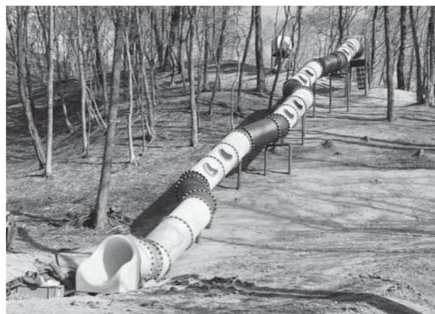
▲更新した万葉クリエートパークの滑り台
