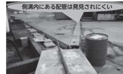
状況：送油管の裏が老朽化により穴が開き、油漏れが発生した。
