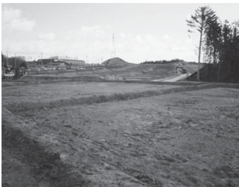
▲工事が進むときわ台南団地
