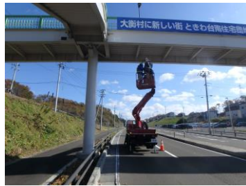
写真－2 高所作業車による点検状況
