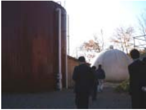
図 46 木質発酵槽(左)とガスボイラー(右)
