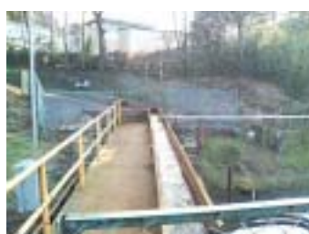
図 33 上北沢排水処理施設の流入水
