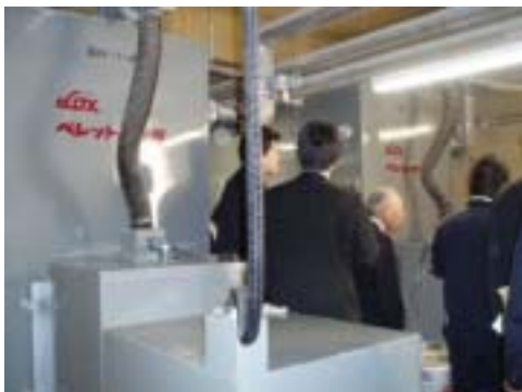
図 49 ペレットボイラー
