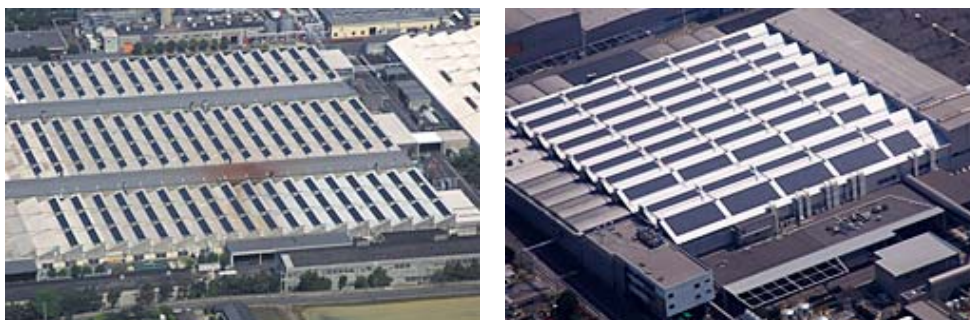
図 41 トヨタ自動車（株）堤工場に設置された2,000kW 太陽光発電（愛知県豊田市）
