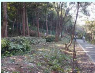
緩衝帯の整備
