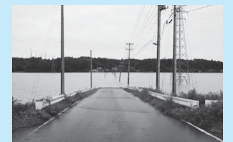
▲関東・東北豪雨の被害の様子(衡下地区)
