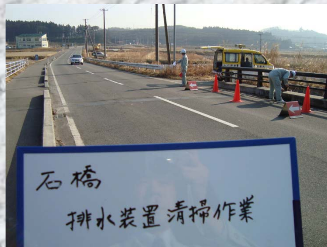
日常の維持管理の実施状況(土砂撤去)
