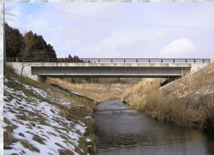
石橋(コンクリート橋)平成15年
