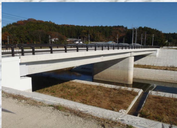
野畑松本線雁又橋 架替え工事の写真
